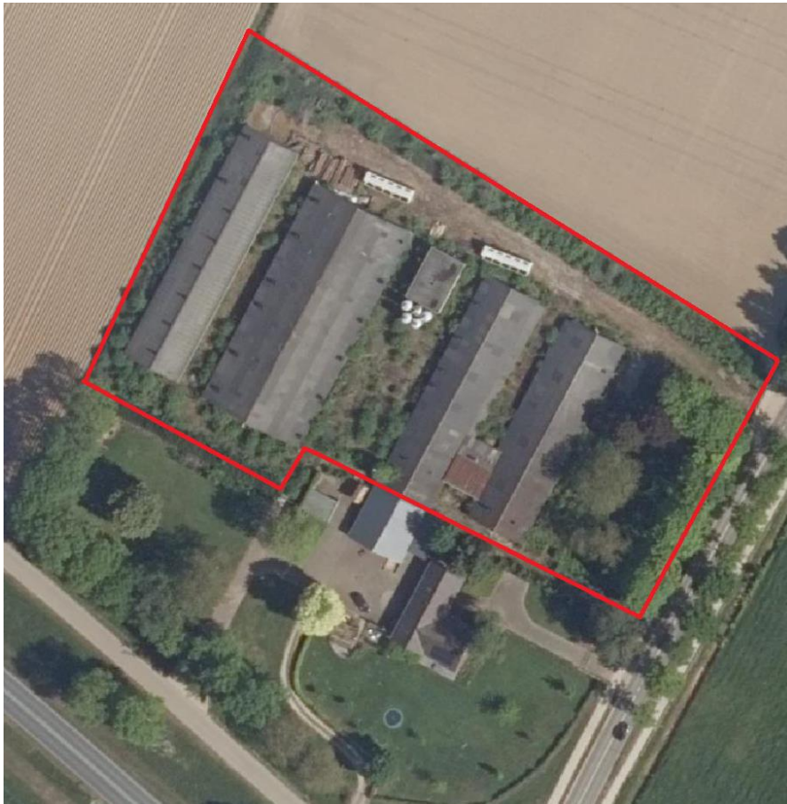
Afbeelding 4: Luchtfoto van het plangebied (bron: www.ruimtelijkeplannen.nl )
