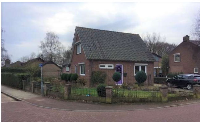
bestaande woning aan de Molenweg 28
