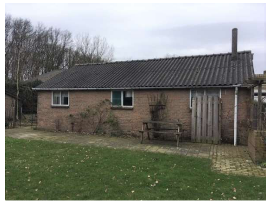
schuur op het erf
