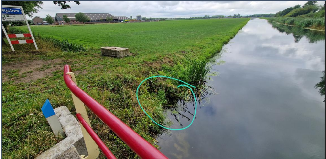
Figuur 6: De Nieuwe wetering vanaf de brug Wilhelminalaan. Omcirkeld de duiker van de tertiaire watergang ten westen van de Wilhelminalaan
