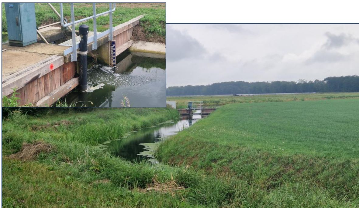
Figuur 7: stuw tussen de Nieuwe Wetering BLM005 en de watergang ten oosten van de Wilhelminalaan BLM025.
