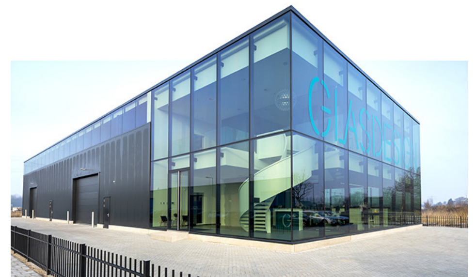
Architectonische uitwerking van kantoor en bedrijfshal zijn evenwichtig, herkenbare representatieve voorgevel.
