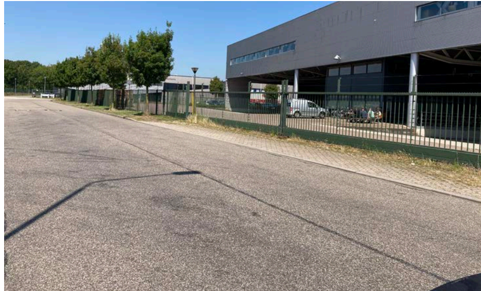
Spijlenhekwerk in mosgroen zorgt voor samenhang met bestaande bedrijventerrein Bijsterhuizen.
