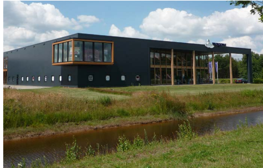
Architectonische uitwerking van kantoor en bedrijfshal zijn evenwichtig.
