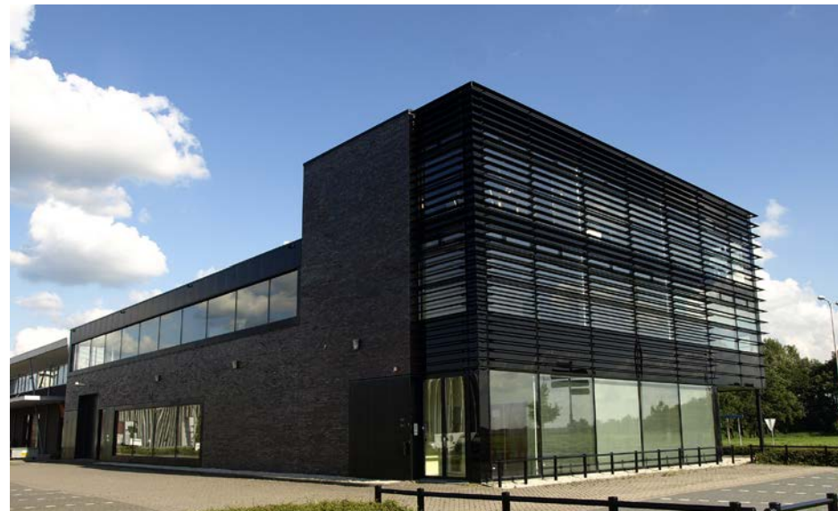
Effectieve zonwering mee ontwerpen met de architectuur van het gebouw.
