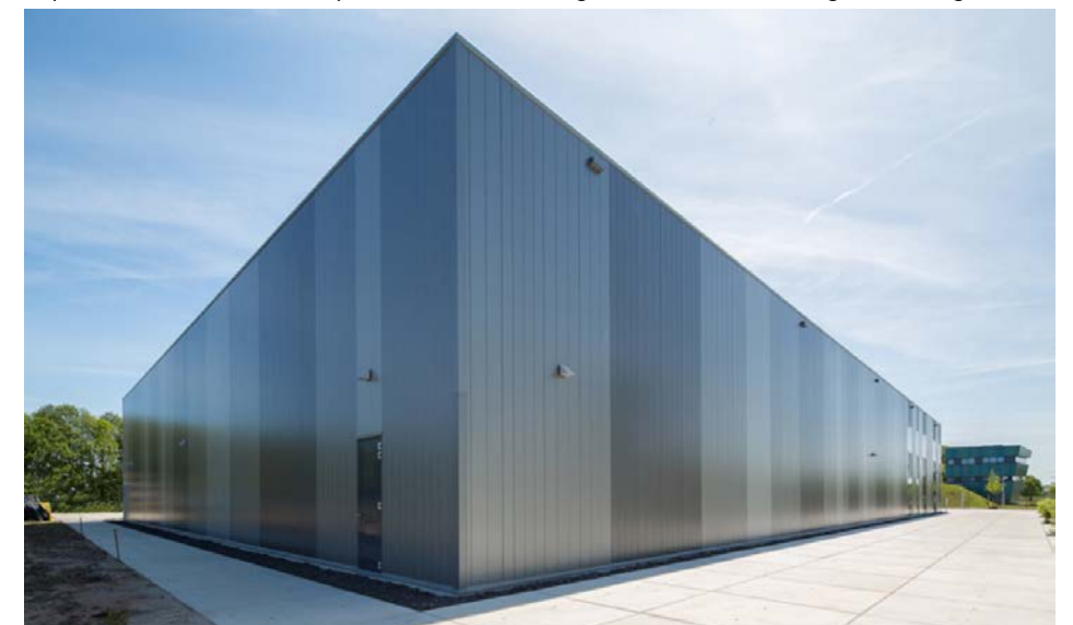
Samenhangende gevel met verticale vlakverdeling
