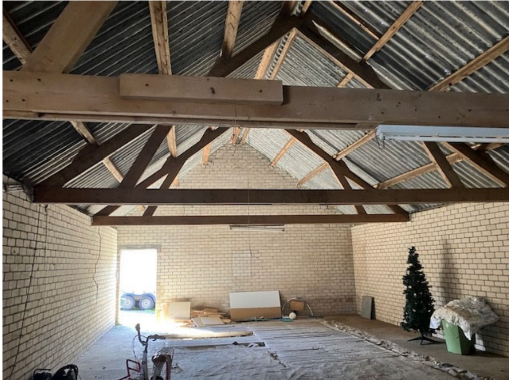
• Afbeelding 11: binnenzijde te slopen schuur (voorste schuur op het erf)
