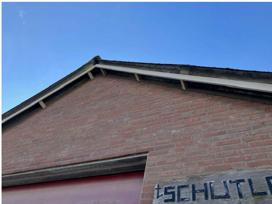
• Afbeelding 12: voorgevel te slopen schuur (voorste schuur op het erf), aansluiting golfplaten met gevel is aan buitenzijde dicht gesmeerd met specie
