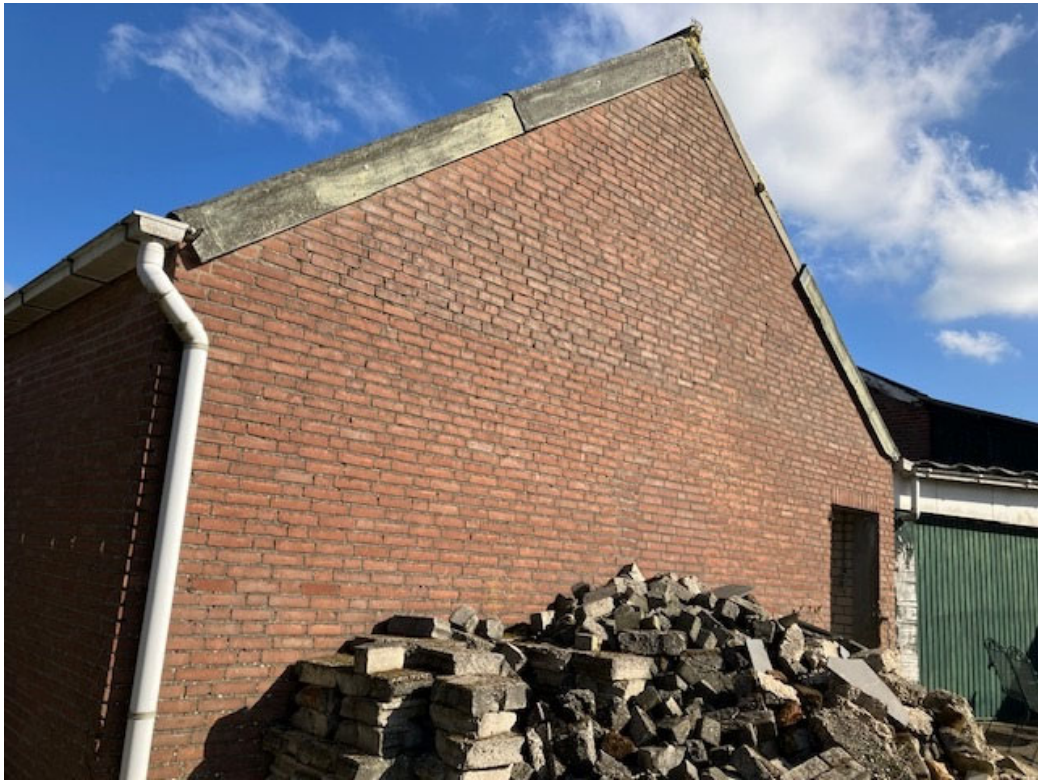
• Afbeelding 7: achterzijde te slopen schuur
