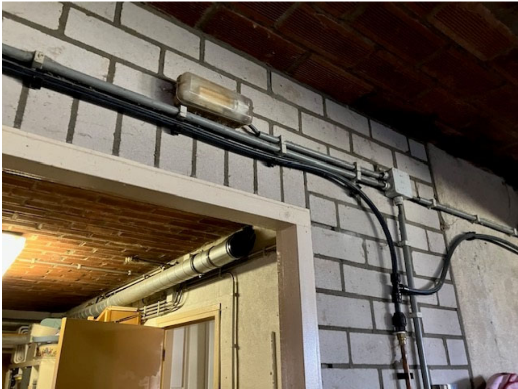
• Afbeelding 17: scheidingsmuur tussen te slopen deel en te behouden deel
