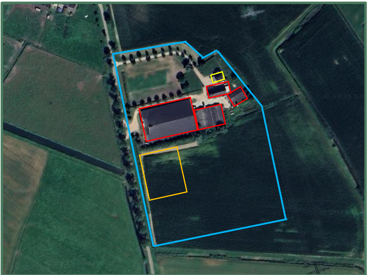
Afbeelding 3: Globaal omljnd plangebied in blauw. Te slopen bebouwing in rood, te behouden bebouwing in geel, beogd bouwvlak twee wooneenheden in oranje omkaderd. Bron: Google Earth.
