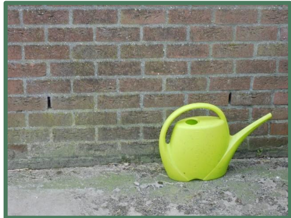
Foto 26: Open stootvoegen te laag bij de grond.
