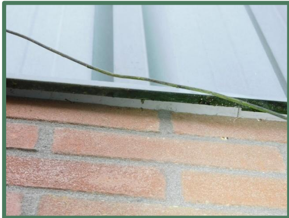
Foto 25: Lat achter damwandpaneel.
