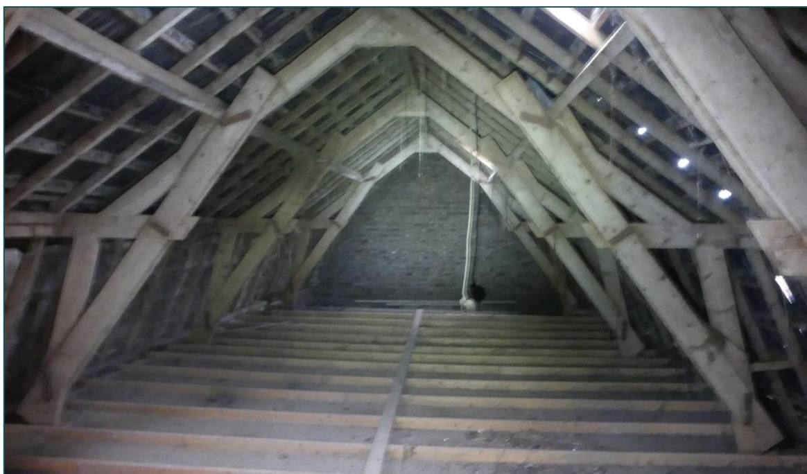
Figuur 3.3 Zolder van gebouw 4.
