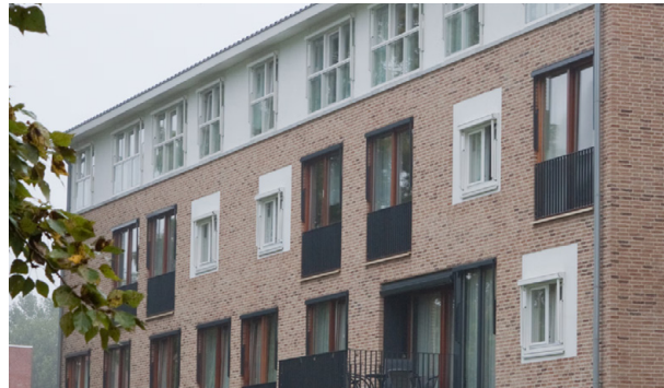
Betreft de aspecten: derde laag bestaat uit andere materialisatie, overstekende goot en de verschillende kaders rondom de ramen, kozijnen en balkons
