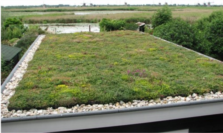
Figuur 2 Voorbeeld van een groen plat sedumdak, zonder extra beplanting en zonder uitrusting
