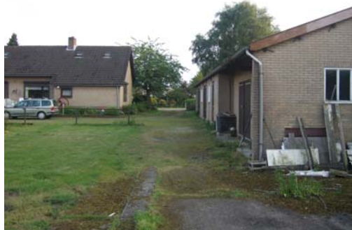
Foto 10: achterzijde woning met bijgebouw
