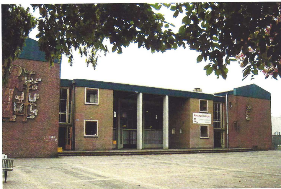
Voormalige jongensschool Sint Franciscus gebouwd in 1955 –1956 naar ontwerp van de Wijchense architecten Sluitman en Rijcken. De school is gelegen aan de Oosterweg te Wijchen. De voorgevel is uitgevoerd in traditionele baksteen.
