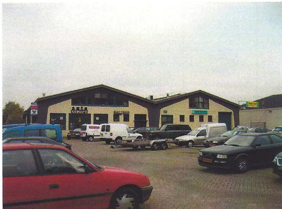
Bedrijfshal met winkel aan de Nieuweweg. Het gebouw valt op door eenvoudig uit te breiden constructie met kniespanen.
