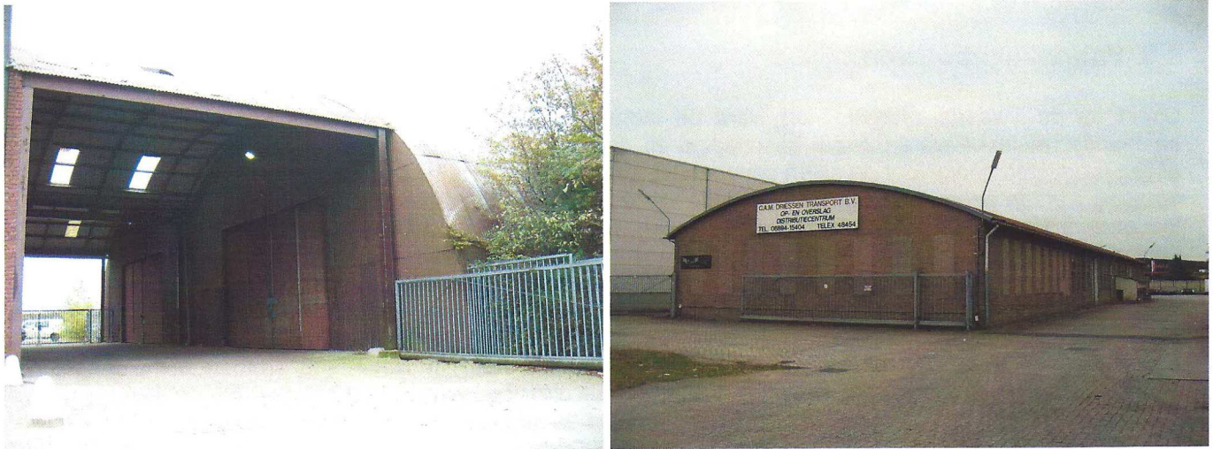
Industrieterrein Nieuweweg te Wijchen: bedrijfshal gebouwd met gebruikmaking van het Romneysysteem (links) en een bedrijfshal met schaaldak (rechts).
