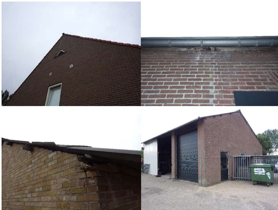
Figuur 4.1 Impressie van de ruimtes die door vleermuizen gebruikt zouden kunnen worden als verblijfplaats of die mogelijk toegang verschaffen tot de spouwmuren. Linksboven een kopgevel van het woonhuis, rechtsboven schade onder de dakgoot, linksonder schade aan een van de varkensstallen en rechtsonder de ruimte tussen de kopgevel en dakbedekking van de voormalige paardenstal
