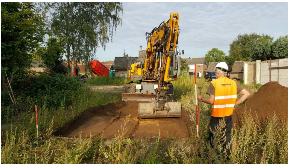
Afbeelding 2 Aanleg werkput 1, gezien vanuit het westen. Bron: foto Vestigia (22-08-2017).
