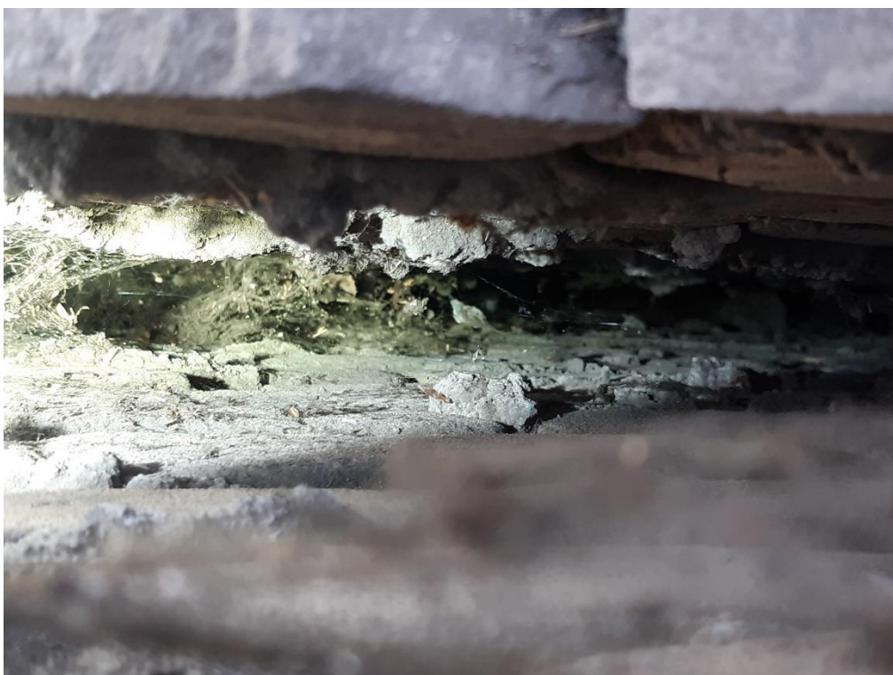
Figuur 15. De spouwen van de voor- en achtergevel van de grote schuur konden gecontroleerd worden door de dakpannen erboven op te tillen.
