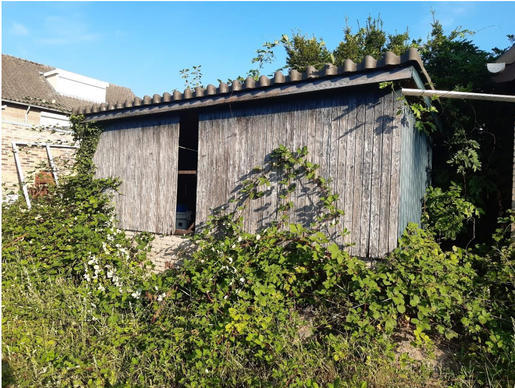
Figuur 6. De kleine schuur heeft grotendeels enkelvoudige houten wanden en een pannendak.
