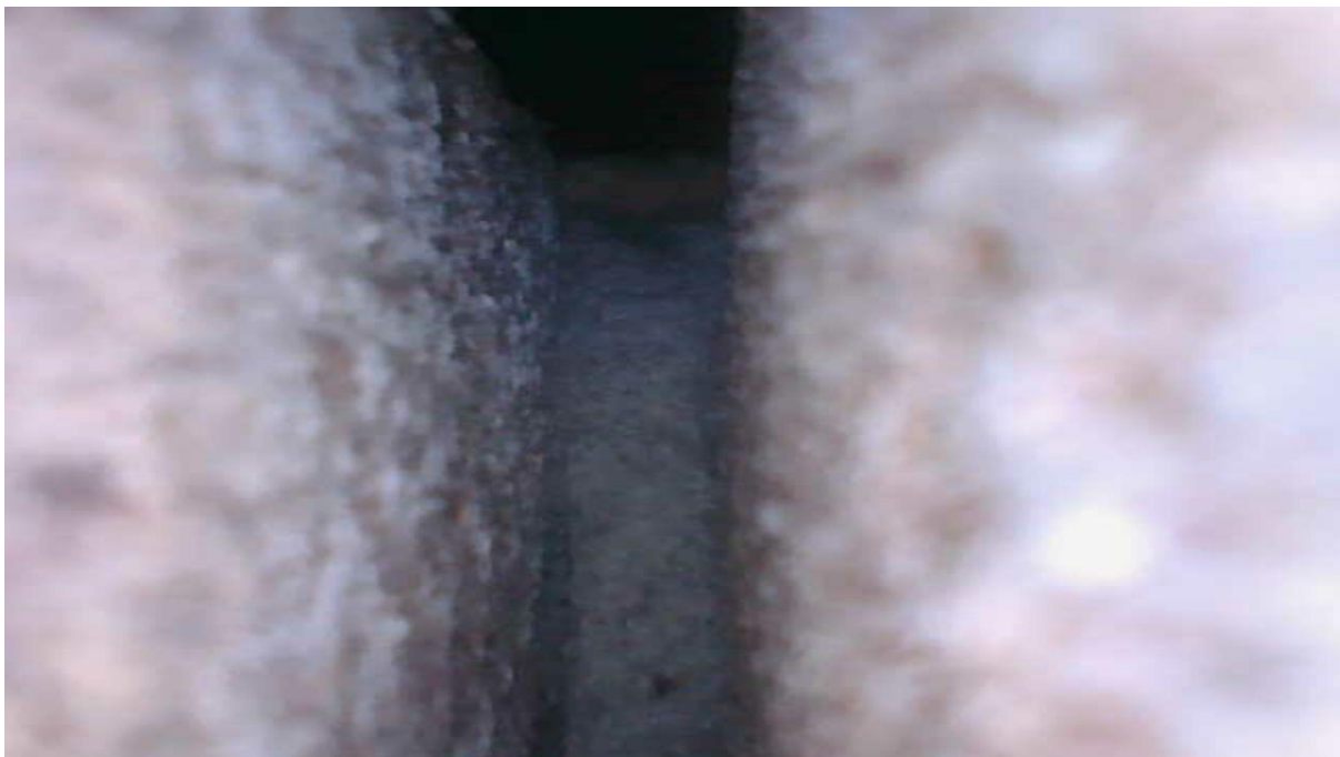
Figuur 16. In de twee zijgevels werd de spouw gecontroleerd met een spouw-endoscoop.
