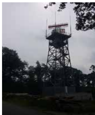
Vliegveld / centrum: radartoren (nog in bedrijf)
