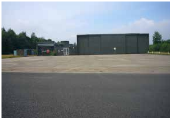
Vliegveld / centrum: hangar-/ veldzijde van demotor-proefopstelling.
