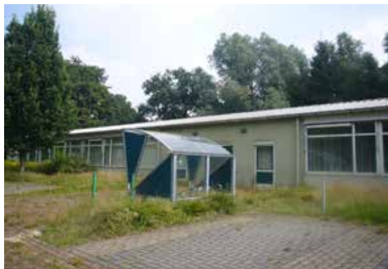
Kantoor-/instructiegebouw cluster westzijde.
