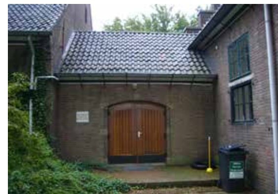
Camouflage architectuur, regionale bouwwijze en materiaal is op verschillende manieren toegepast om de bunker te verhullen.
