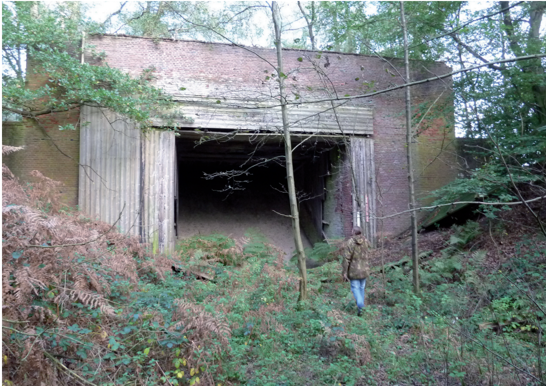
Figuur 23. De kogelvanger van de inschietbaan voor boordwapens.
