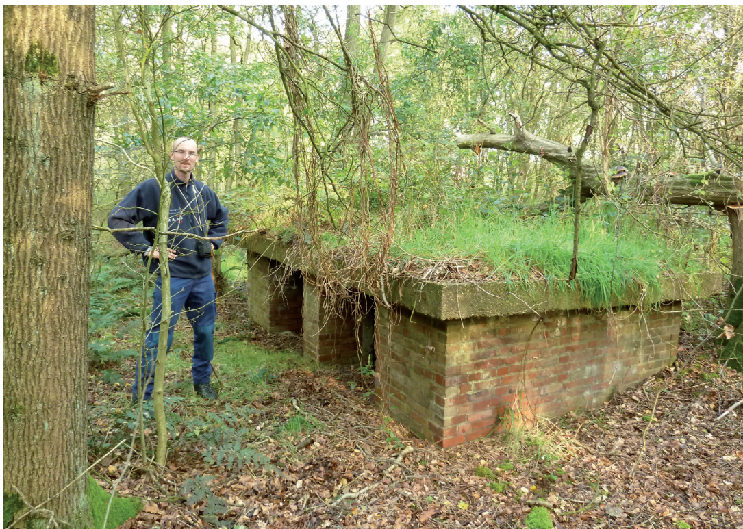
Figuur 18. Een nog intacte Duitse munitiebunker, vermoedelijk geassocieerd met FLAK ten noorden van de Druiventros in deelgebied 1 (inspectie nr. 12).
