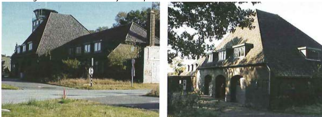
Voormalige brandweerkazerne bij De Strip
