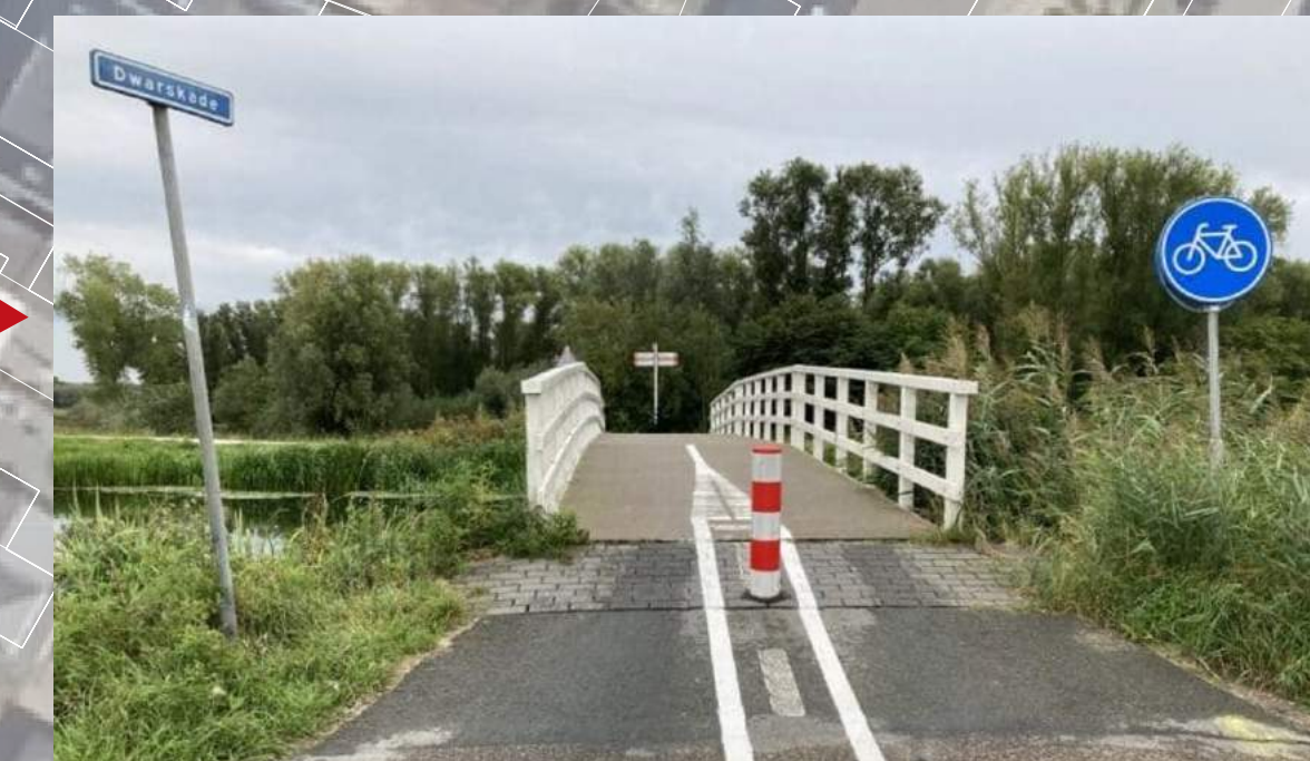
Een tweede aansluiting op de Driemorgen voor langzaam verkeer (voetgangers/fietsers) door middel van een extra duiker. Dankzij een paaltje in het midden kunnen indien nodig hulpdiensten passeren (extra calamiteitenontsluiting).
