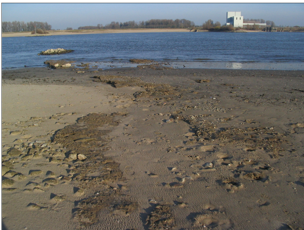
Figuur 10. Restant van een vermoedelijk 19e-eeuwse krib op het strand van de Waal. De kribresten bestaan uit palenrijen met een tussenliggend pakket klei en resten van biezenmatten. Deze opbouw is representatief voor een periode waarin grootschalige inzet van bazaltblokken nog niet gebruikelijk was en men aangewezen was op lokaal materiaal zoals kleibonken, hout en biezen.
