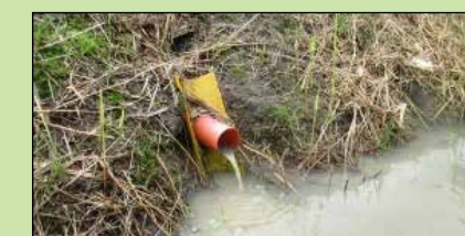
afwerken bestaande drainage
