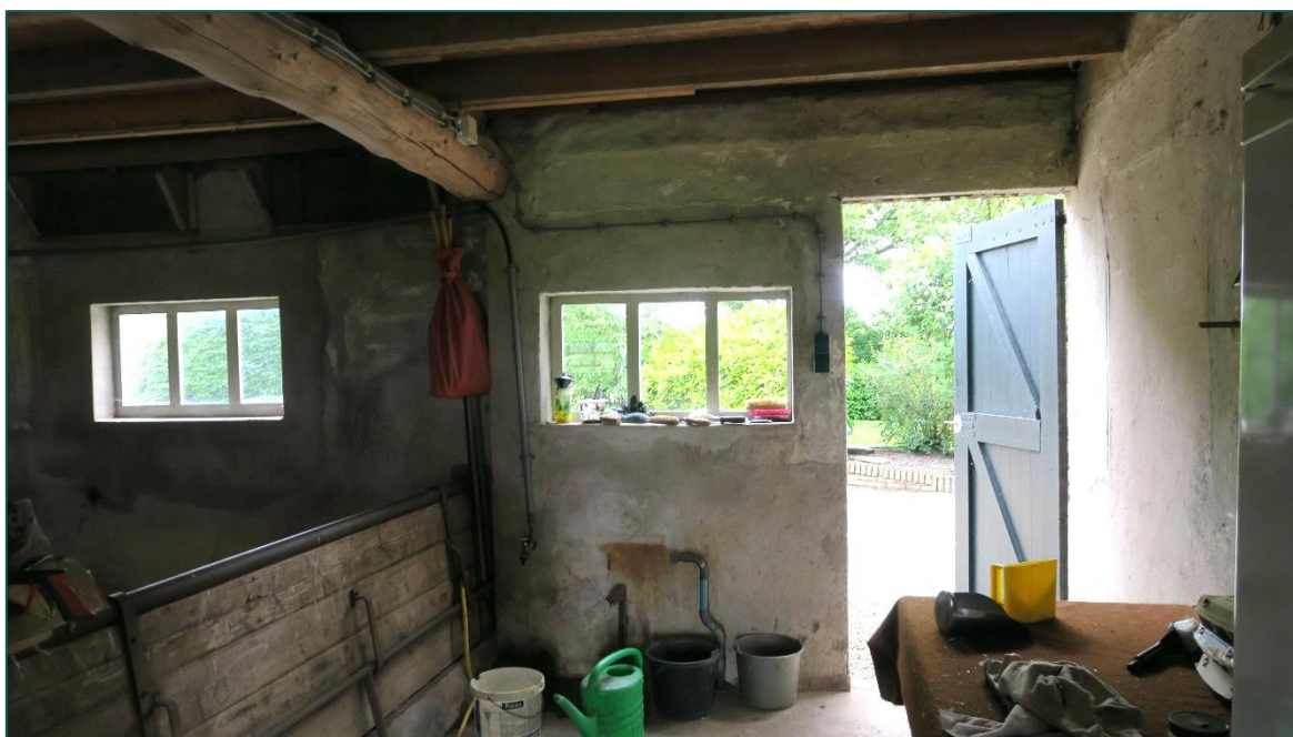
Figuur 2 De te slopen schuur bestaat uit diverse ongebruikte stallen en opbergruimtes.
