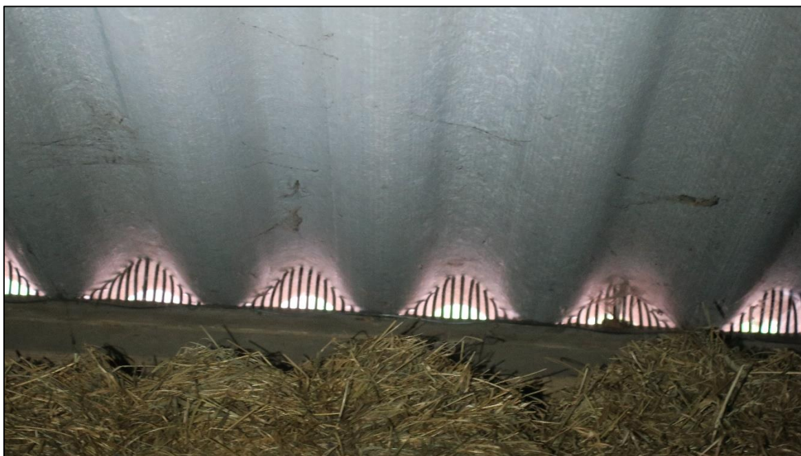
Figuur 3.4 Openingen tussen golfplaten dak en baksteenmuren zijn afgedicht met vogelschroot.
