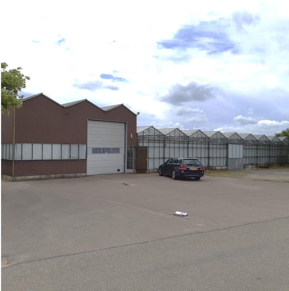
Afbeelding 13: Impressie van de onderzoekslocatie ten tijde van het booronderzoek. Foto genomen vanaf de Kloosterweg in zuidelijke richting.
