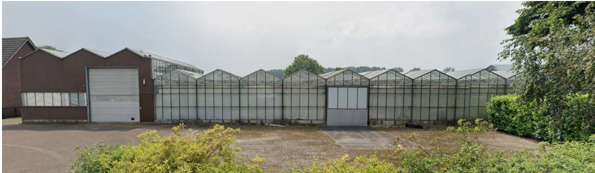
Foto van het bestaande, te amoveren kassencomplex
