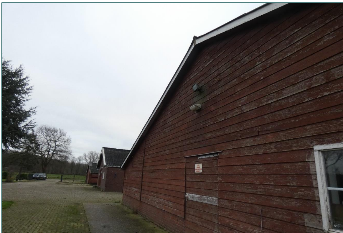
Figuur 1 De planlocatie is gelegen aan de Neersteindsestraat 11 te Horsen en bestaat uit een boerenerf met bijgebouwen. De beoogde ruimtelijke ingreep betreft de sloop van drie kippenschuren en een paardenstal.
