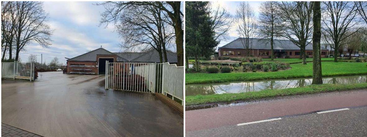
het bedrijfspand van aannemersbedrijf Hoes met ingang aan de Goorstraat en de gevelzijde aan de Molenweg
