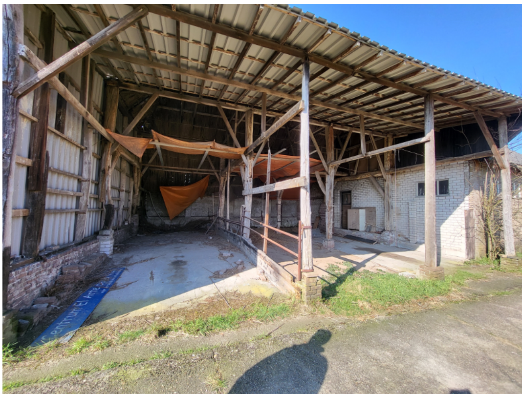
Foto 14 Omschrijving overkapping achter schuur
