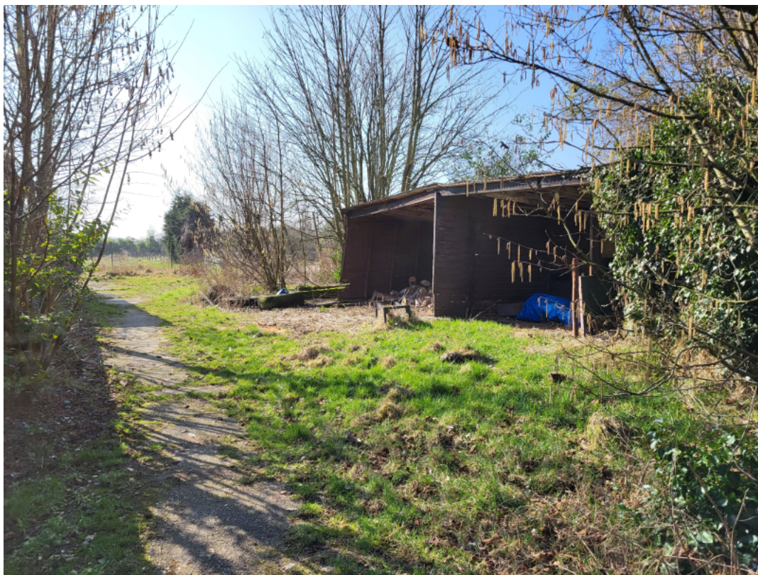
Foto 15 Omschrijving overkapping (stook)hout
