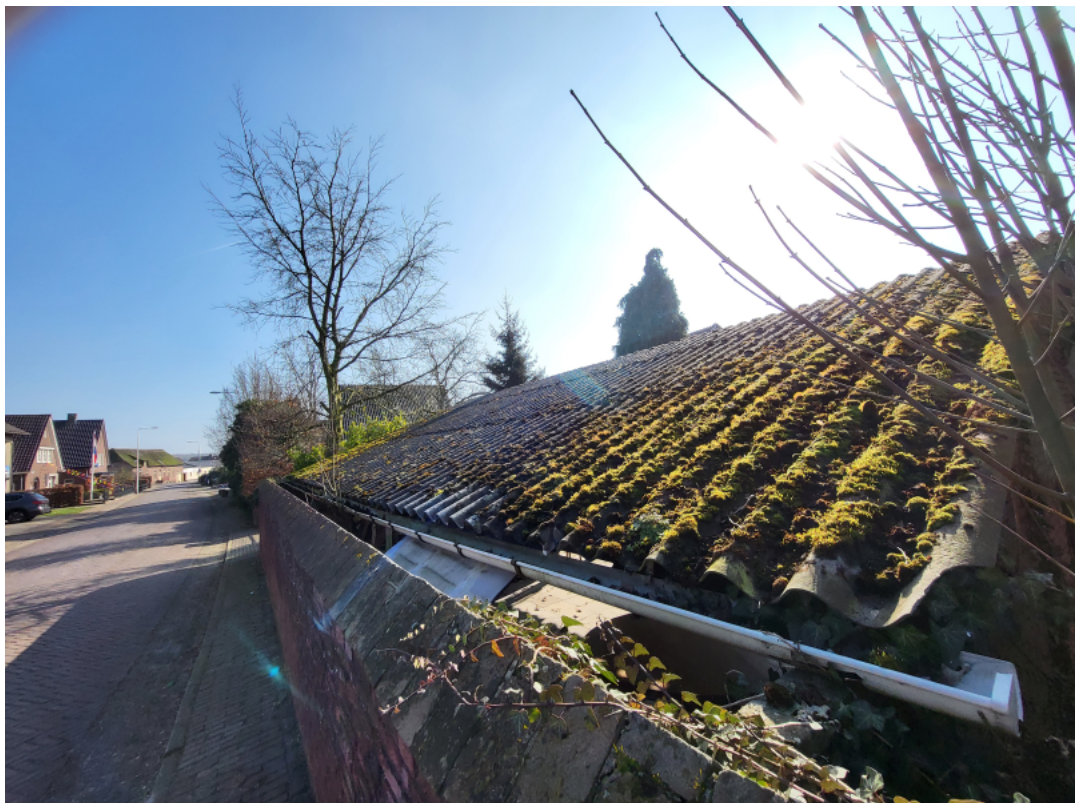
Foto 2 Omschrijving overkapping voorzijde
