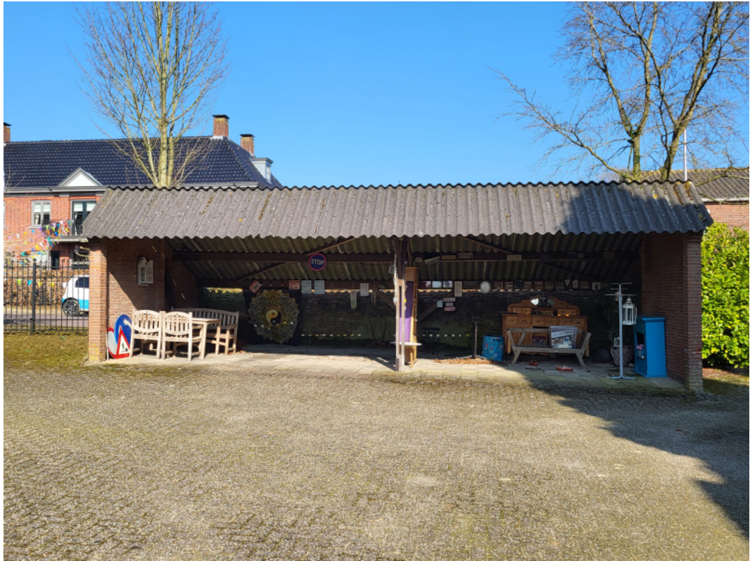
Foto 1 Omschrijving overkapping voorzijde
