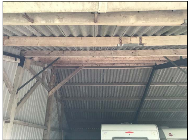
FIGUUR 9 INTERIEUR ENKELWANDIGE KAPSCHUUR
