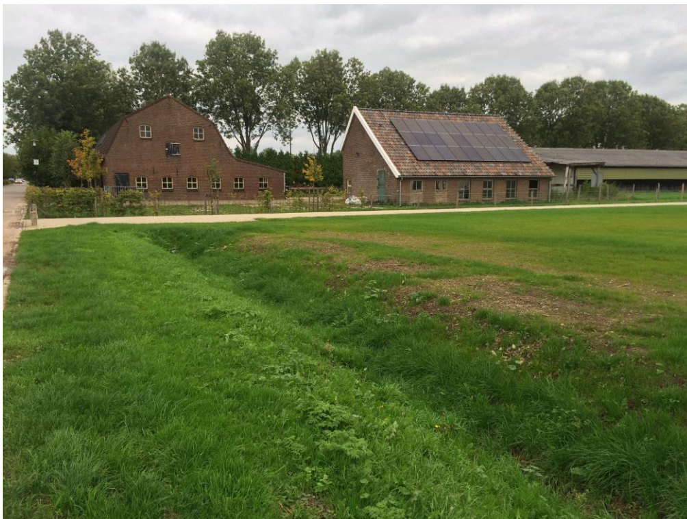
Sloot zoals aanwezig aan de westzijde van het plangebied
