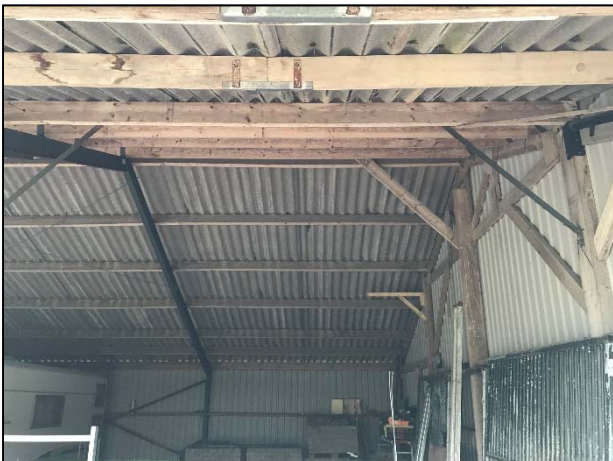
FIGUUR 8 INTERIEUR ENKELWANDIGE KAPSCHUUR
