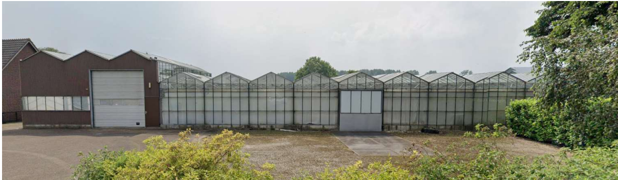
Foto van het bestaande, te amoveren kassencomplex
