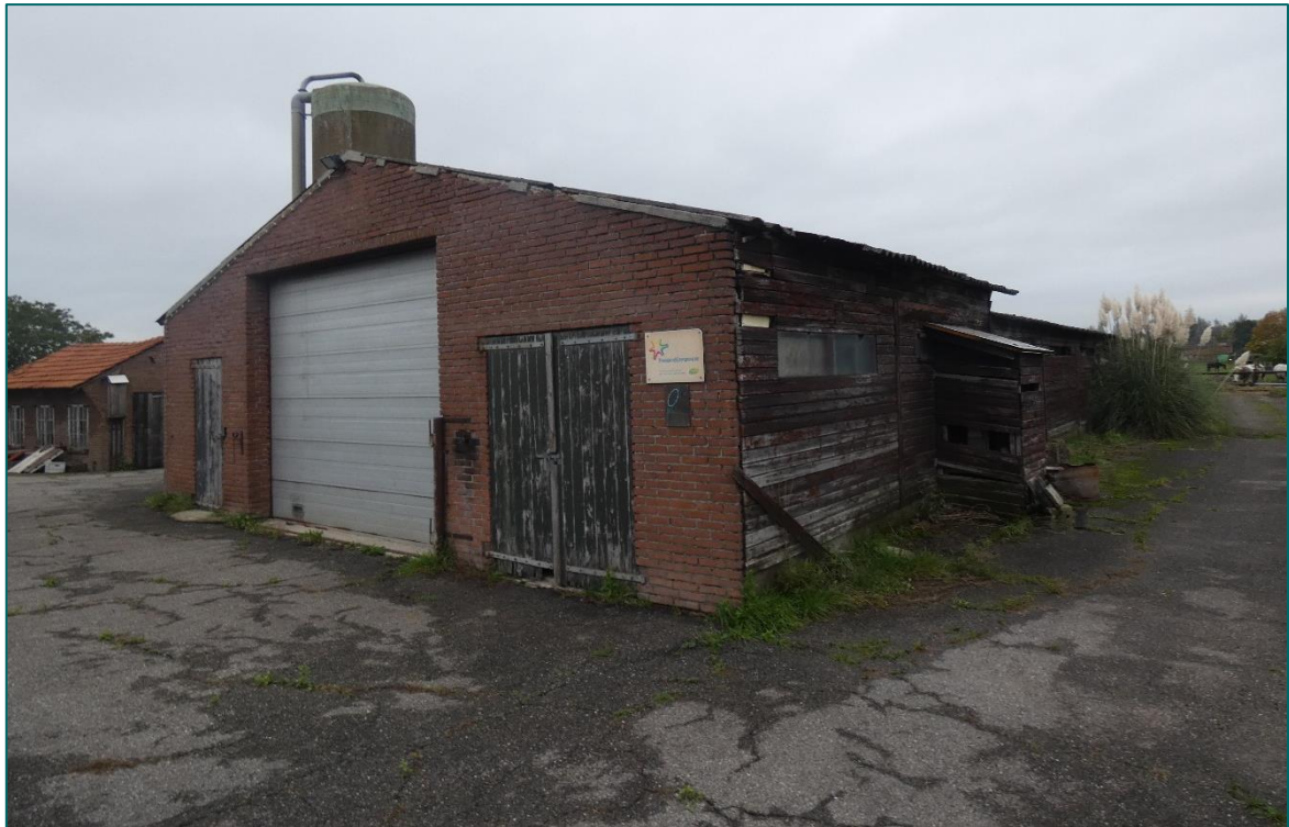
Figuur 3 Schuur 2 op de planlocatie is deels opgebouwd uit bakstenen muren en deels uit houten muren. Er is een golfplaten dak aanwezig.
