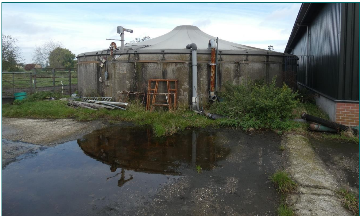
Figuur 8 De te slopen silo (6) op de planlocatie.
