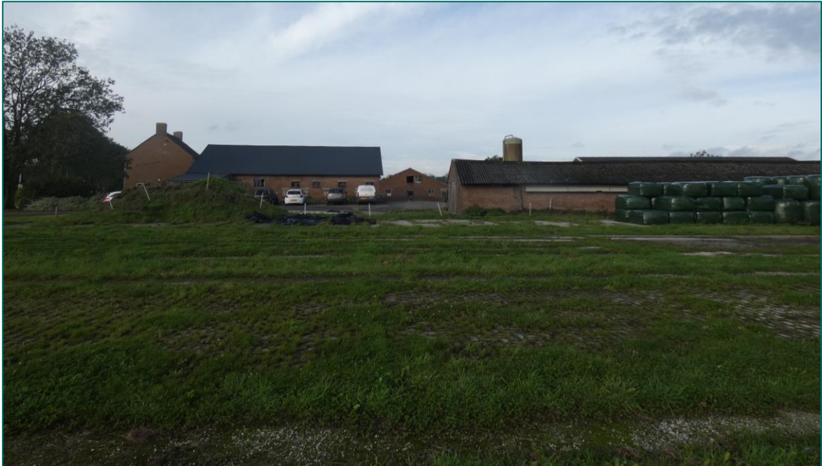
Figuur 1 De planlocatie is gelegen aan de Koningstraat 73 te Afferden en bestaat uit een boerenperceel met onder andere woningen en meerdere schuren. De beoogde ruimtelijke ingreep betreft de sloop van vier schuren en een silo en het verplaatsen van één schuur.
