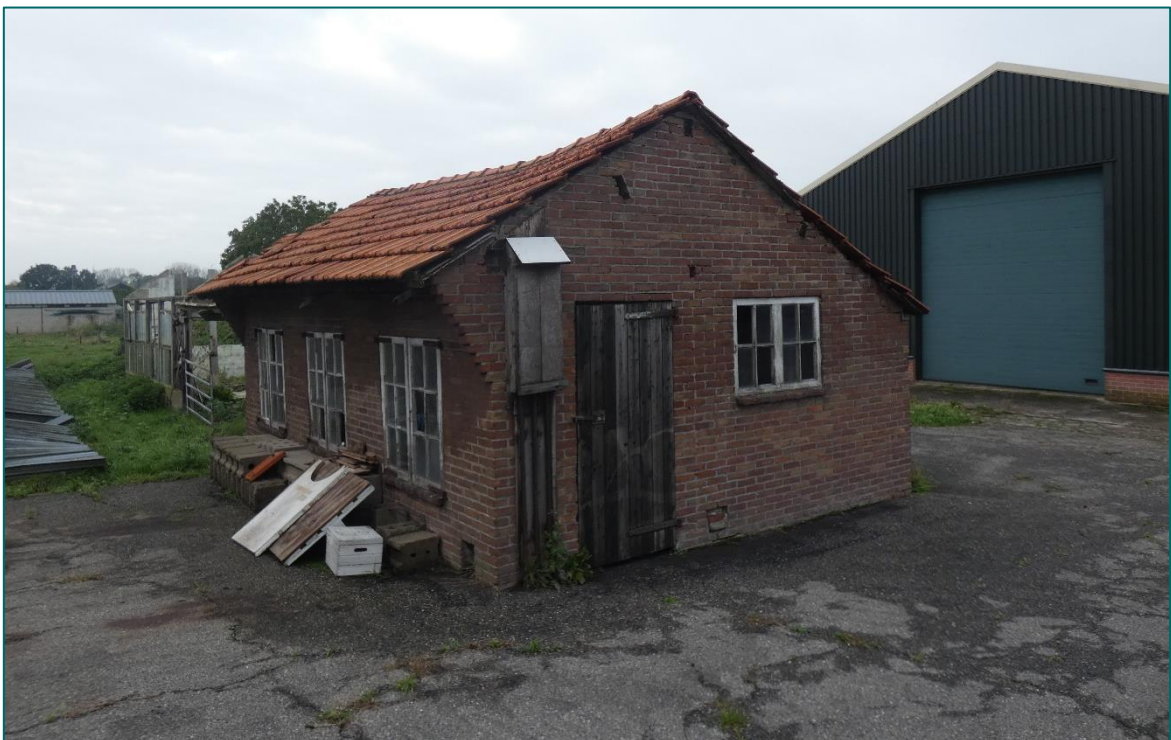
Figuur 6 Schuur 4 op de planlocatie is opgebouwd uit bakstenen muren zonder luchtspouw en heeft een dakpannen dak.
