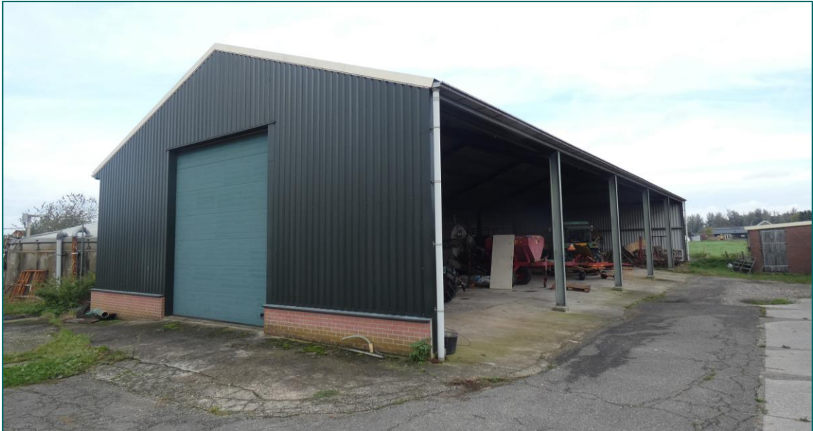
Figuur 5 Schuur 3 is volledig opgebouwd uit damwandplaten en zal binnen de planlocatie verplaatst worden.
