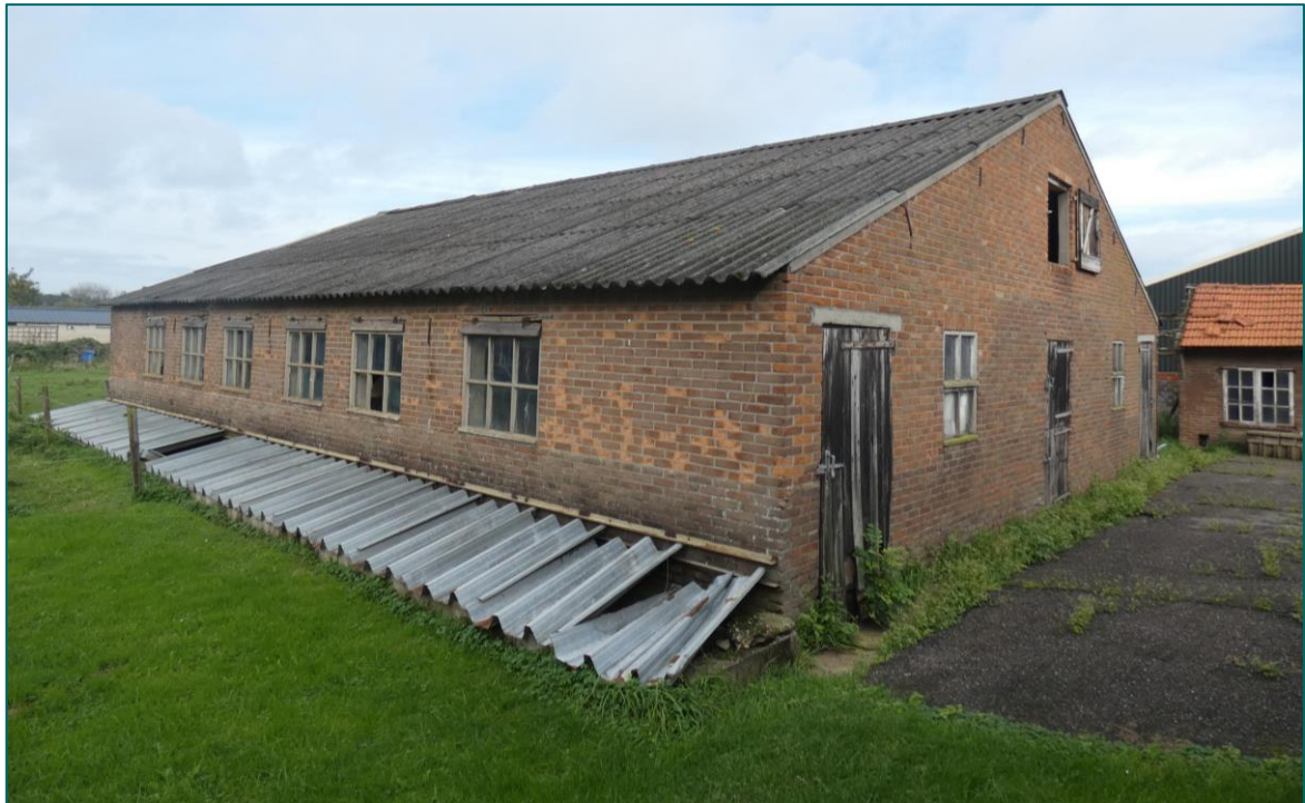
Figuur 7 Schuur 5 op de planlocatie is opgebouwd uit bakstenen muren zonder luchtsouw en heeft een golfplaten dak.
