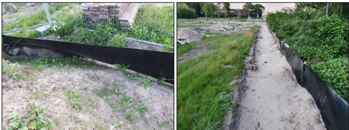
Figuur 3 Een incorrect geplaatst amfibiescherm (links). Een correct geplaatst amfibiescherm (rechts). Deze dienen minimaal 10 cm ingegraven te zijn (bron foto's: Blom Ecologie).
