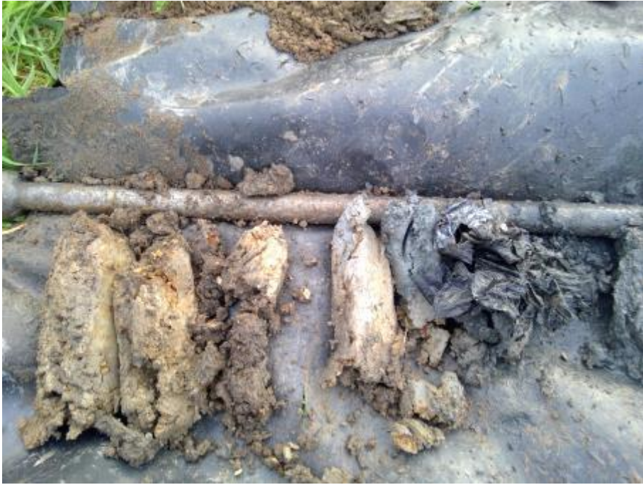
Boring 102, bodemlaag van 1,1 – 1,6 m -mv: Plastic-, puin- en koolresten
