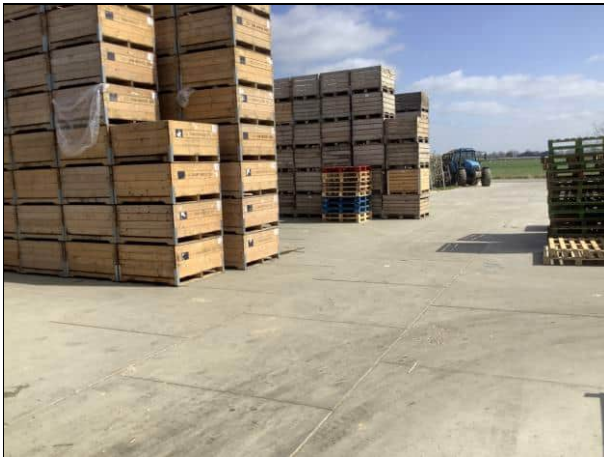
Foto 7 Overzicht stelconplaatverharding met opslag
