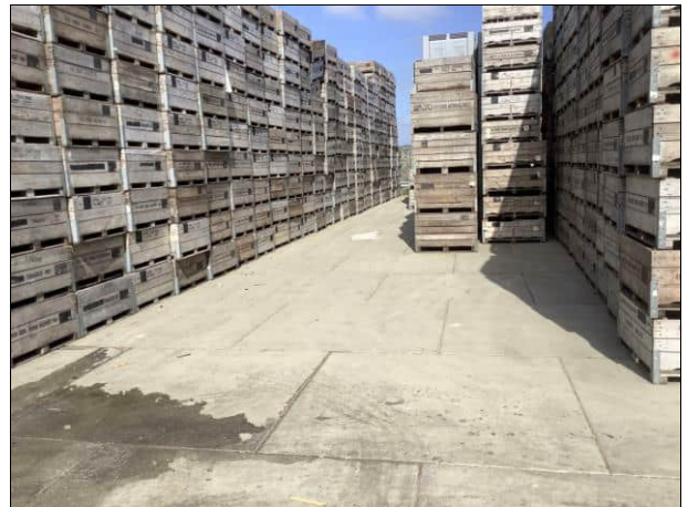
Foto 6 Overzicht stelconplaatverharding met opslag
