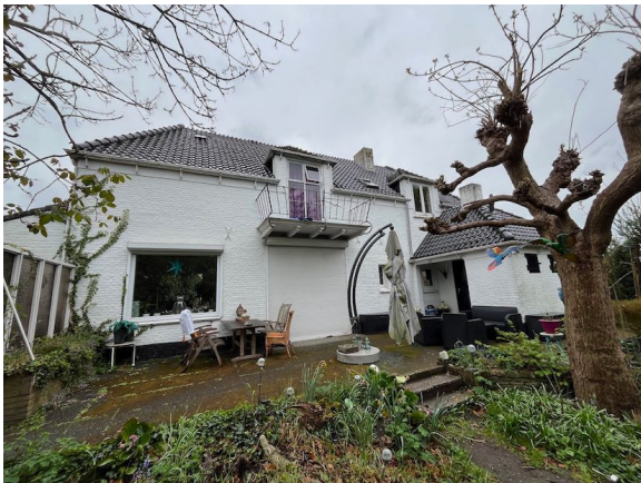
Figuur 14. Zuidgevel gebouw 6.
