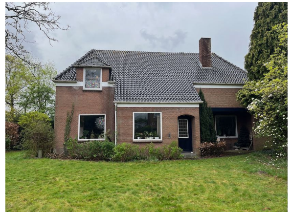
Figuur 13. Noordgevel gebouw 6.
