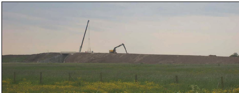
Figuur 9.5 Grondlichaam en viaduct de Slaper t.b.v de Hanzelijn [R. Toeter, 2009]
