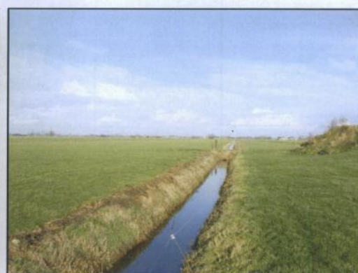
Foto 2. Sluis in het plangebied, locatie nieuwbouw
