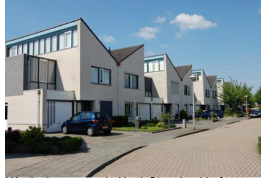
Woningbouw aan de Henk Steenbeekhof.
