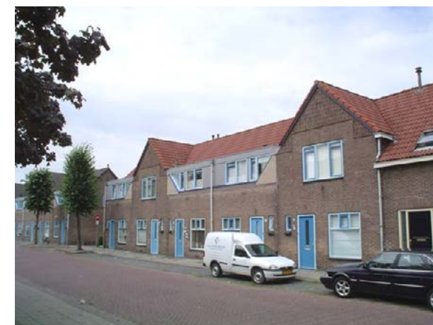
Veel oorspronkelijke detaillering is verdwenen of veranderd.
