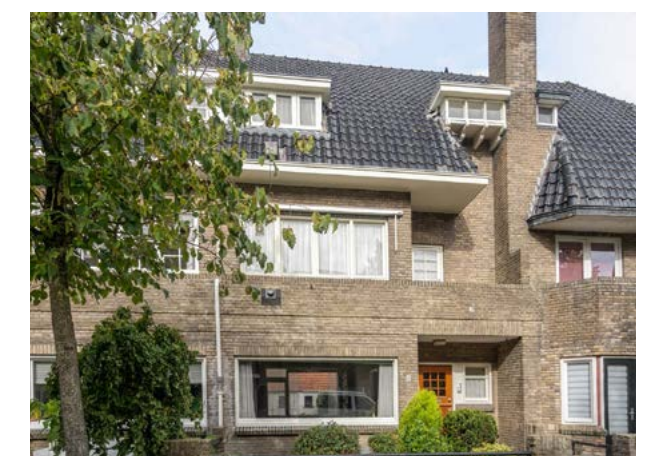
Burgermanswoning, Emmastraat. Architectuur verwant met Amsterdamse School.
