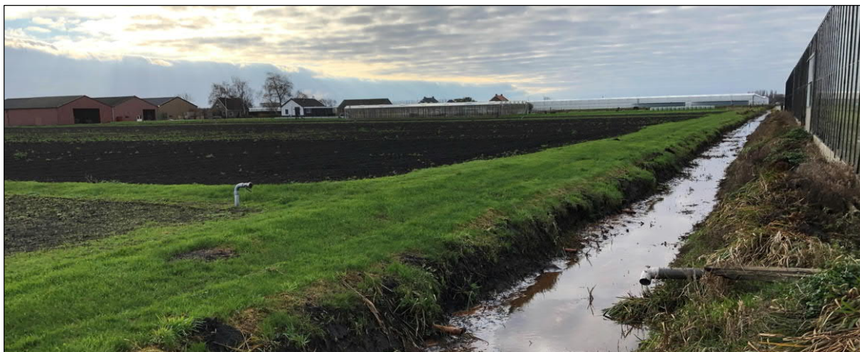
Afbeelding 6: Locatiespecifieke situatie perceel 1531
