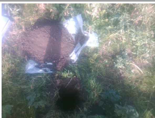
Foto: Inspectiegat A17
