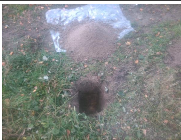
Foto: Inspectiegat C06
