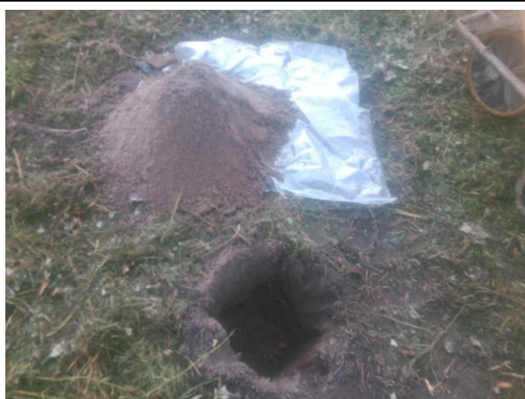
Foto: Inspectiegat C03
