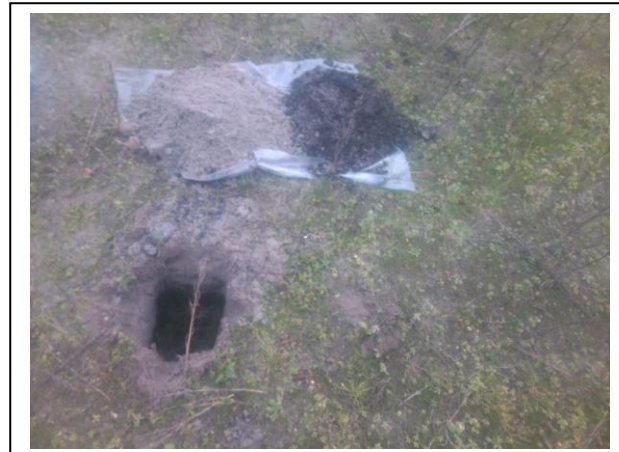
Foto: Inspectiegat D08
