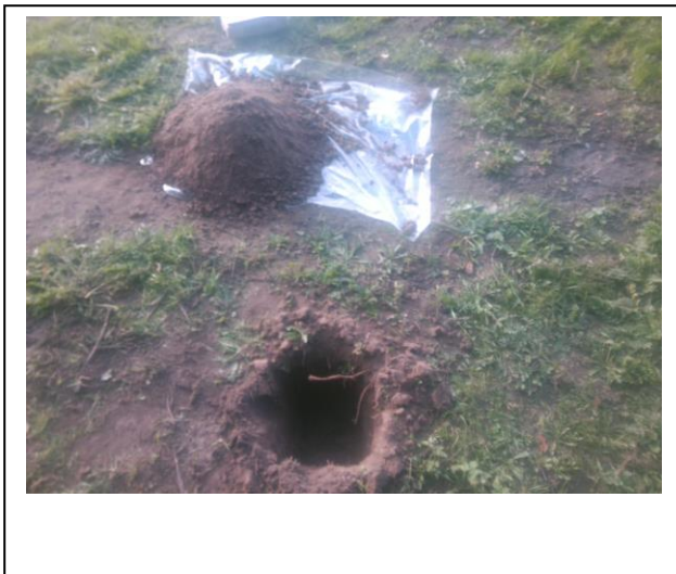
Foto: Inspectiegat C37
