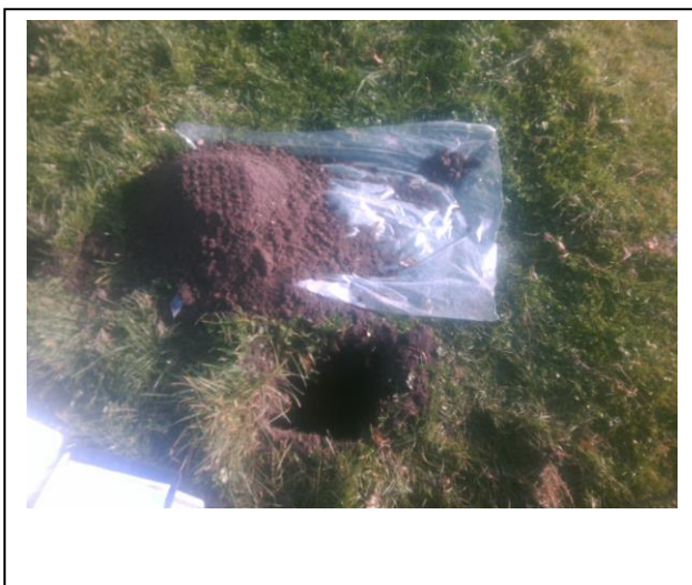
Foto: Inspectiegat A11
