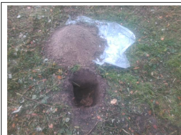
Foto: Inspectiegat C11
