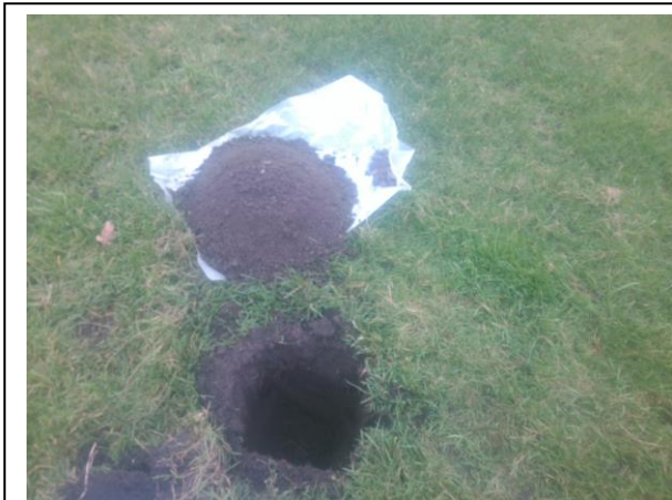
Foto: Inspectiegat B01
