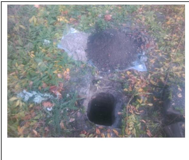
Foto: Inspectiegat A01
