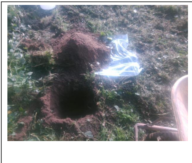
Foto: Inspectiegat C39
