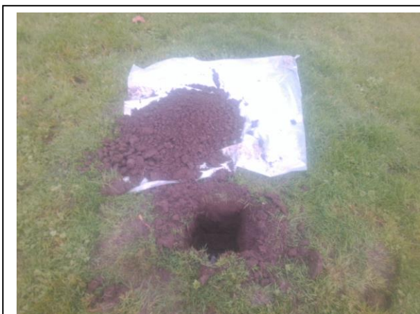
Foto: Inspectiegat D11
