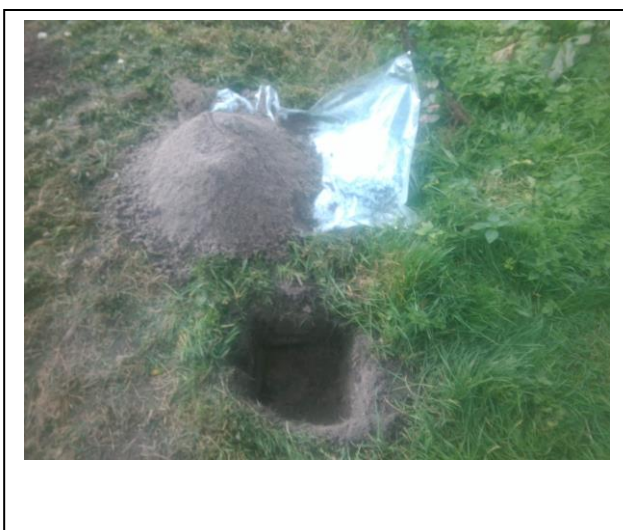
Foto: Inspectiegat C41
