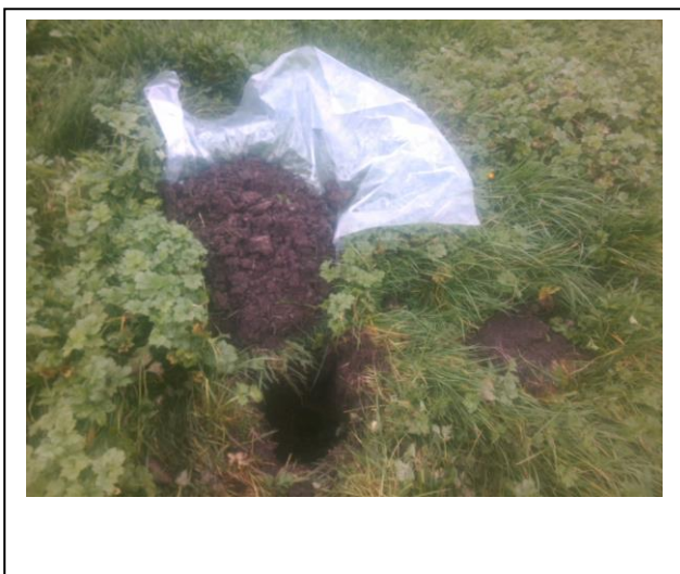
Foto: Inspectiegat D17
