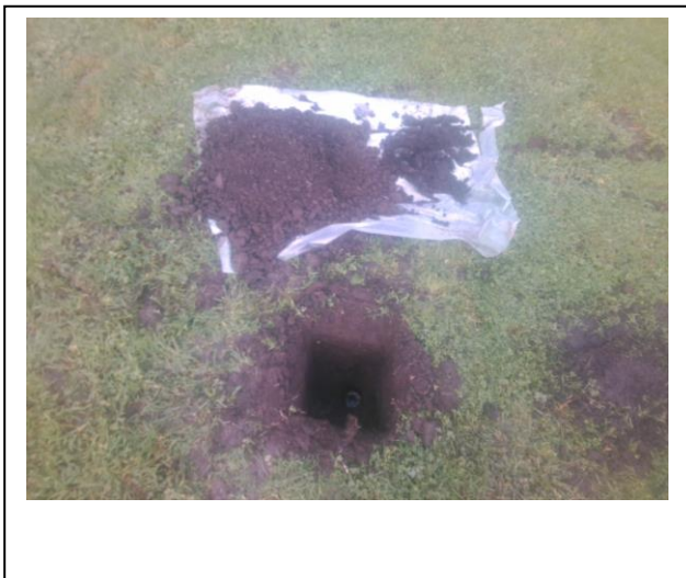
Foto: Inspectiegat D15
