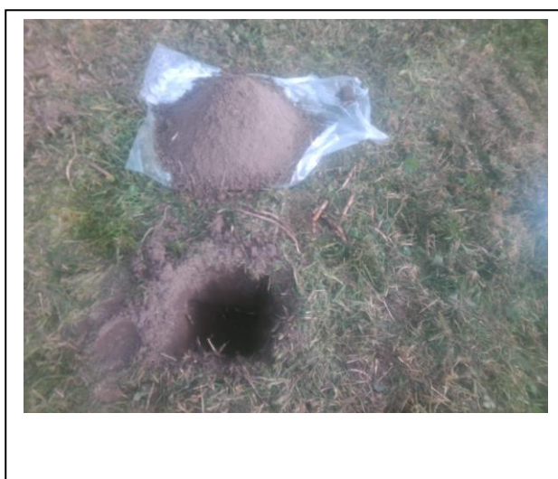
Foto: Inspectiegat C24
