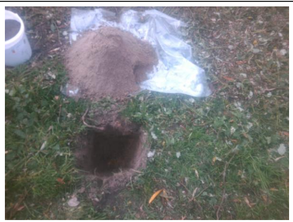
Foto: Inspectiegat C10
