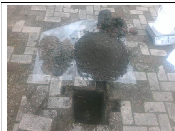
Foto: Inspectiegat D05
