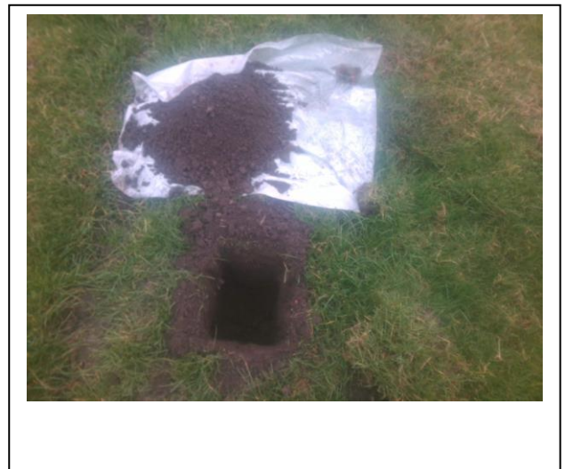
Foto: Inspectiegat B16
