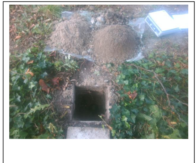
Foto: Inspectiegat A02
