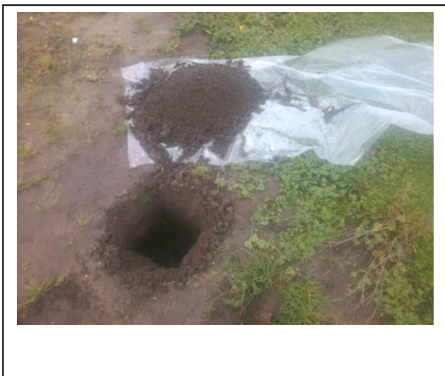
Foto: Inspectiegat D13
