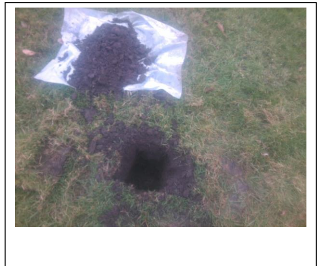
Foto: Inspectiegat B14
