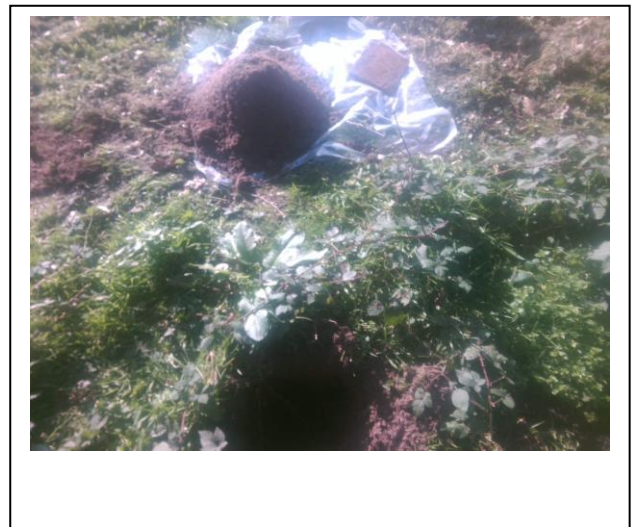
Foto: Inspectiegat C40
