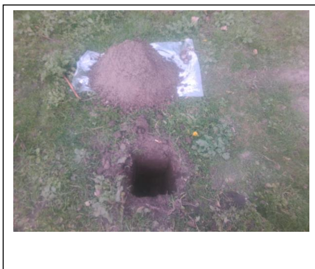
Foto: Inspectiegat C22
