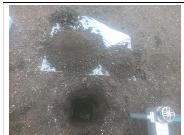
Foto: Inspectiegat D06
