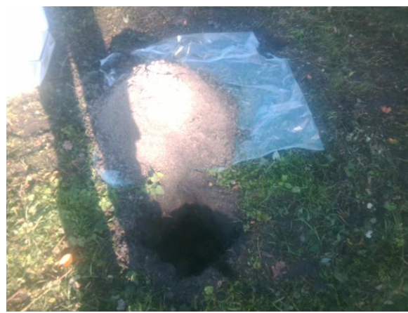
Foto: Inspectiegat C28
