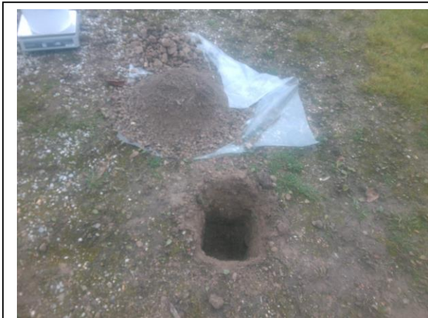
Foto: Inspectiegat D01
