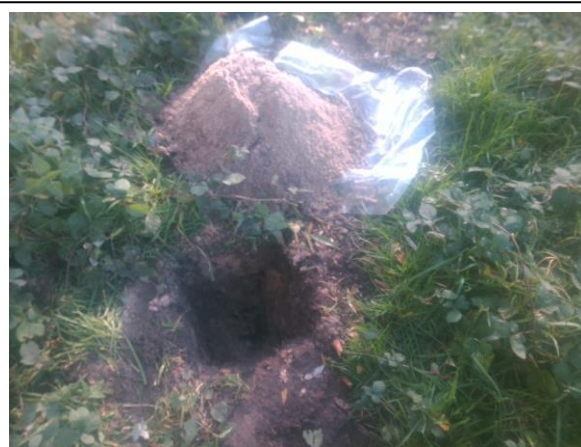
Foto: Inspectiegat C30
