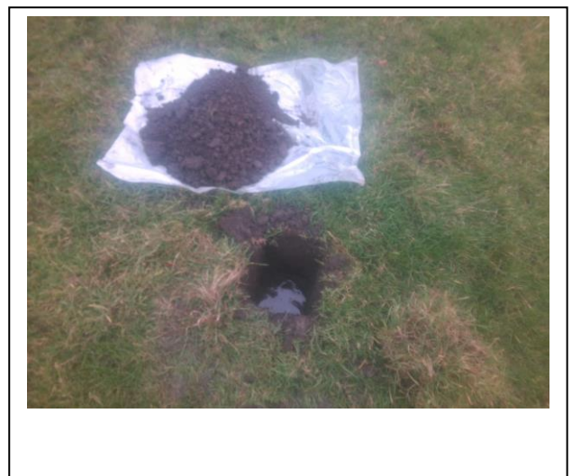
Foto: Inspectiegat B18
