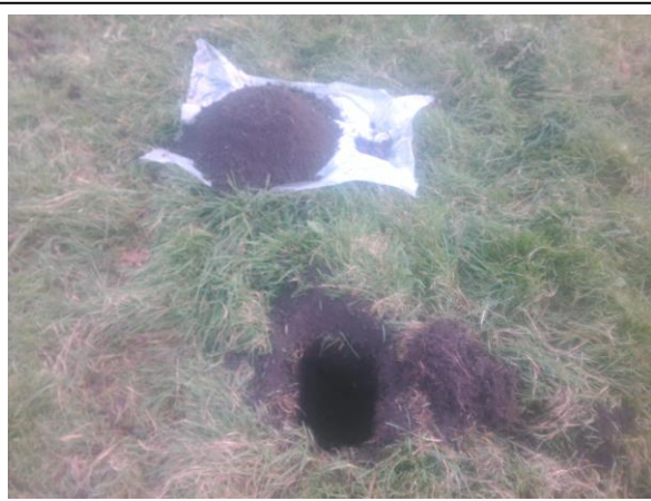
Foto: Inspectiegat A16
