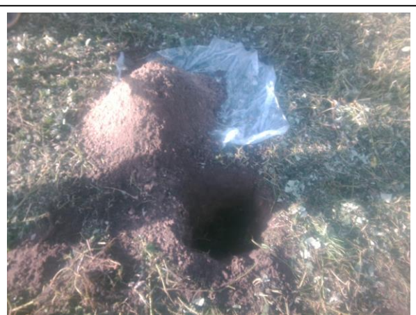
Foto: Inspectiegat C12
