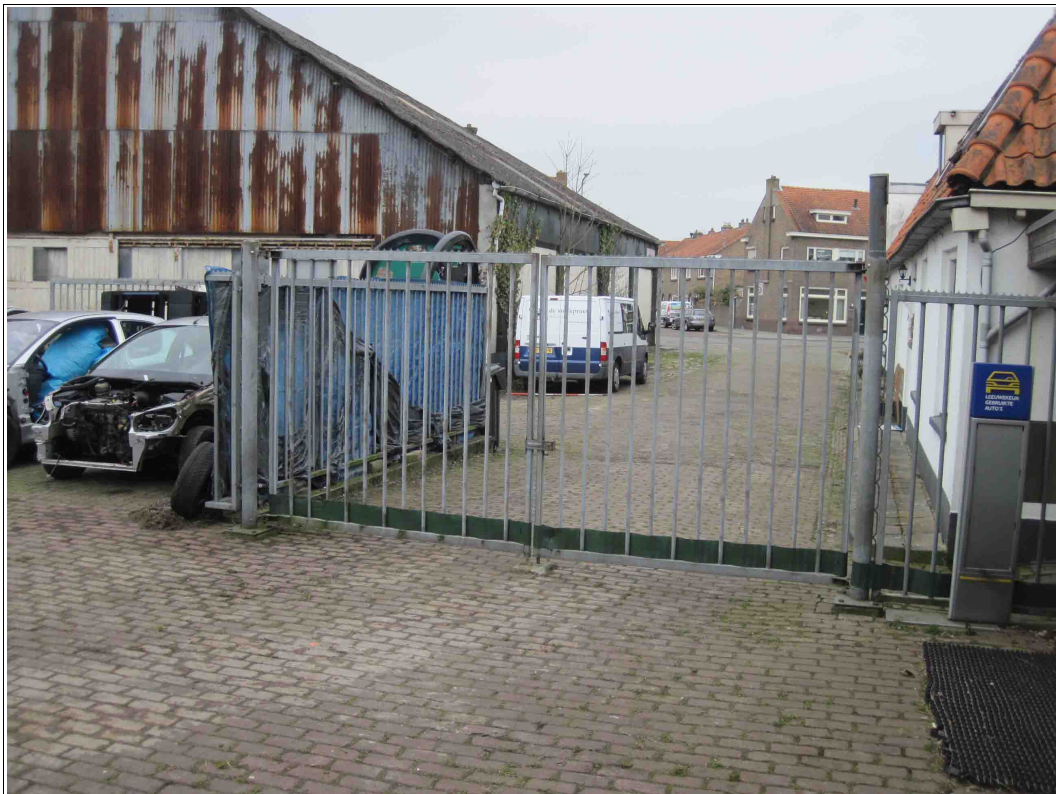
Figuur 2: Kampen, IJsseldijk 26: het plangebied gezien vanaf het terrein in zuidwestelijke richting. Op de achtergrond loopt de IJsseldijk.
