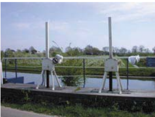
Waterbouwwerk langs de Hollandse IJssel tzv. Hekendorp
