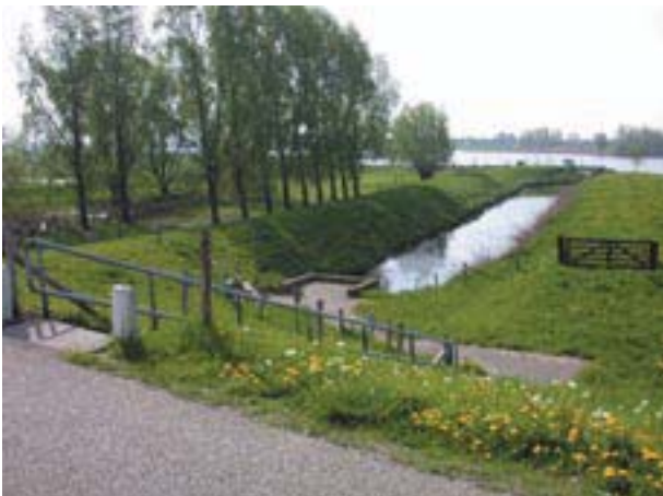
Restanten van de historische inlaat ten zuiden van de Rolafweg Zuid
