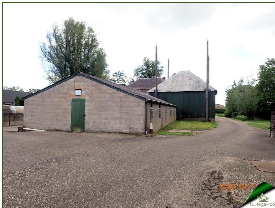
Figuur 8. Opstal 5, voormalige varkensschuur
