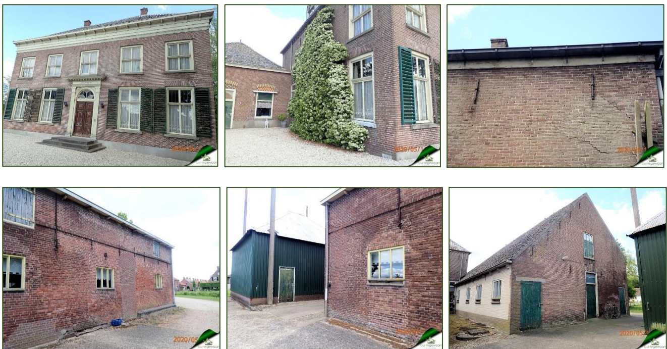
Figuur 5. Fotoregistratie hoofd woning en koetshuis (opstal 1 & 2)
