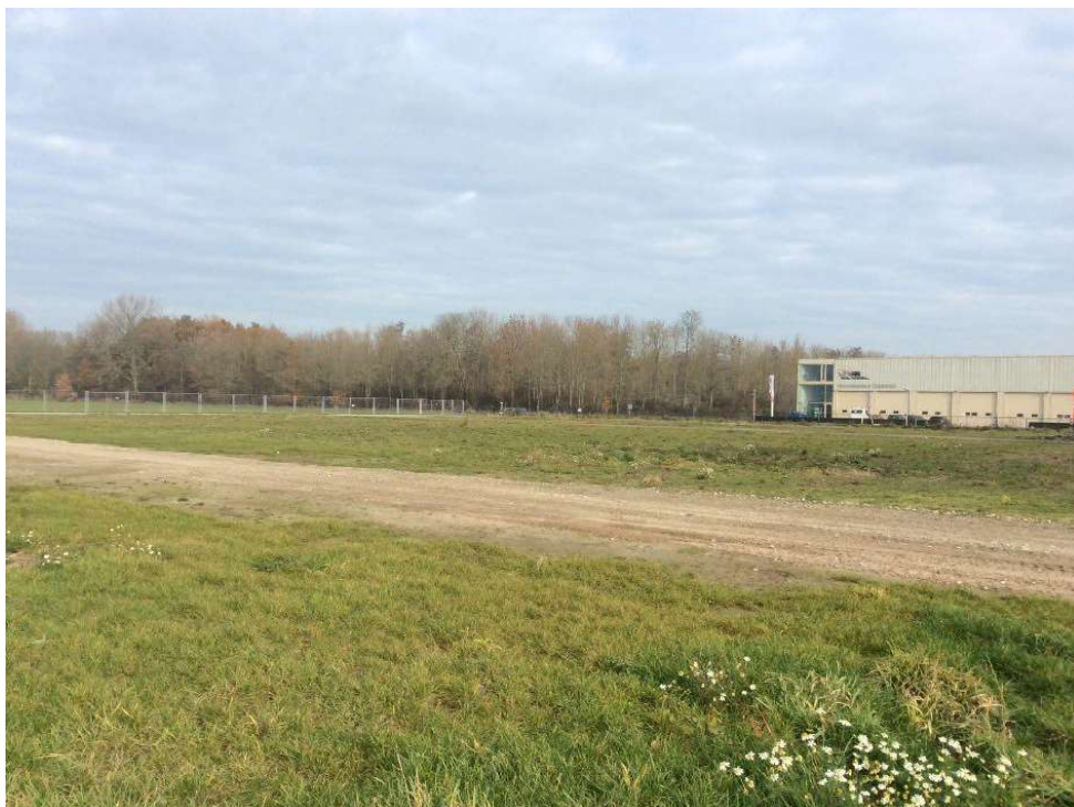
Afbeelding 2: bouwweg met gebroken puin
