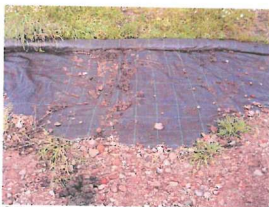
Ophooglaag met gebroken puin gescheiden van het originele maaiveld d.m.v. worteldoek
