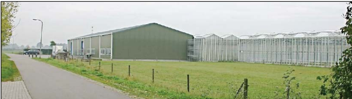
Figuur 9: Aanzicht plangebied vanaf Platveld vanuit het oosten
