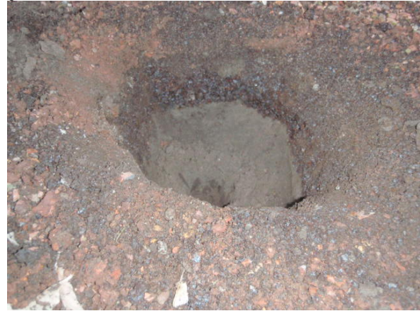
Foto 17: locatie 2, onder de splitverharding is een laag met zinkassen aanwezig.
