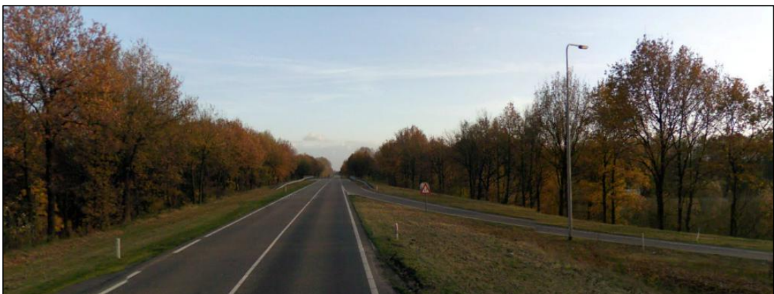
Figuur 2.3: de N277, gezien in noordelijke richting, ter hoogte van de toerit vanaf de N275-N562
