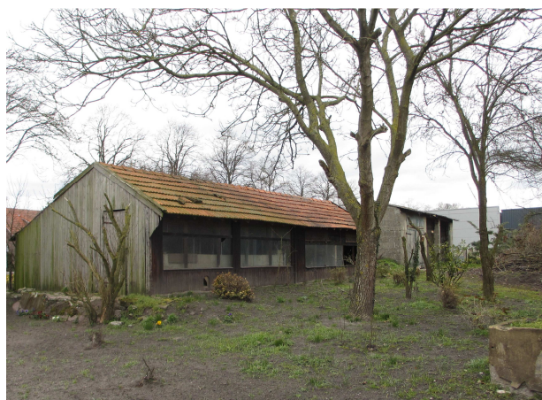
Te slopen schuren op het deel van de boomkwekerij
