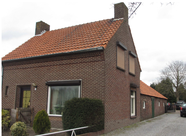
Te slopen woonhuis
