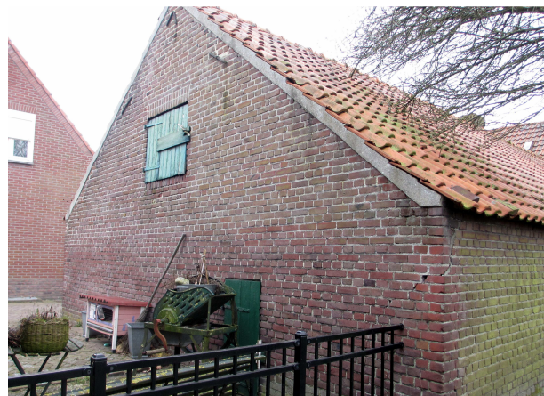
Te slopen voormalige varkensschuur
