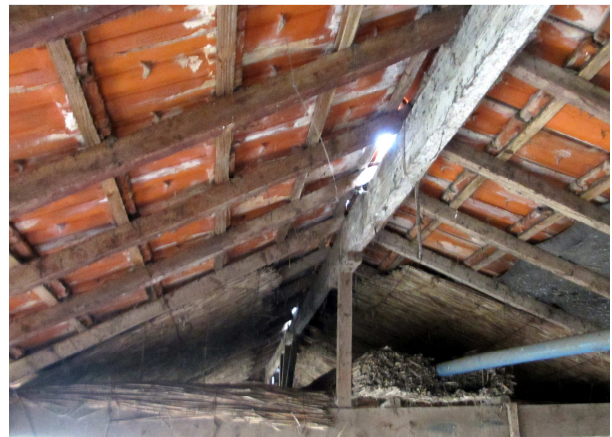
Binnenzijde van het dak van de te slopen schuur, op de boomkwekerij. Geen tussenruimtes, maar wel een rieten mat tegen de onderkant van de dakpannen
