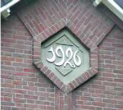
Muur ornament met daarin het bouwjaar van de langgevelboerderij
