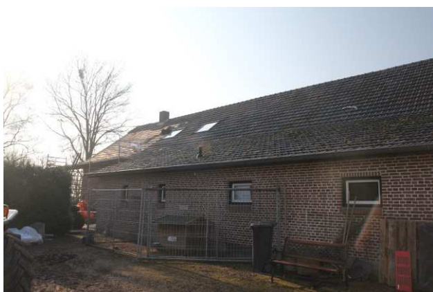
Achtergevel aanbouw tegen schuur.
