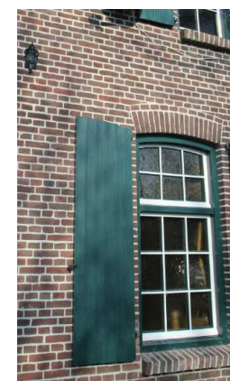
Raam onder segmentboog met rollaag en sieranker (linksboven)
