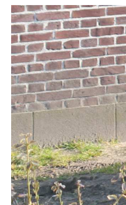
Cementplint met schijnvoegen.
