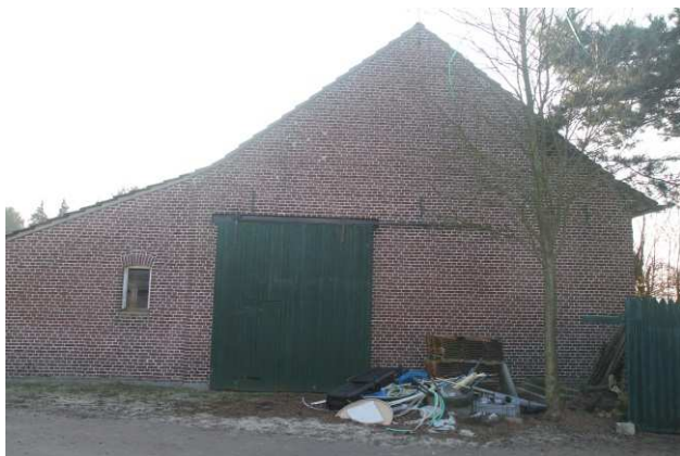
Kopgevel schuur aan aanbouw achtergevel.
