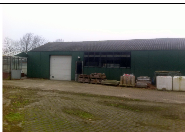
Figuur 4. Te verwijderen loods
